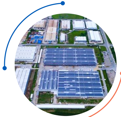
Daikin GES 5,7 MWp | Türkiye | Çatı GES
